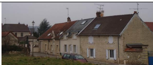
Rue du Haut de la Ville depuis le lotissement des Fontenilles
